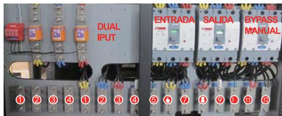
Figura 5.6. Terminales de conexión ups 160 kva
